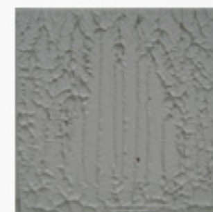
Cubrimiento del 100% por doble encolado
