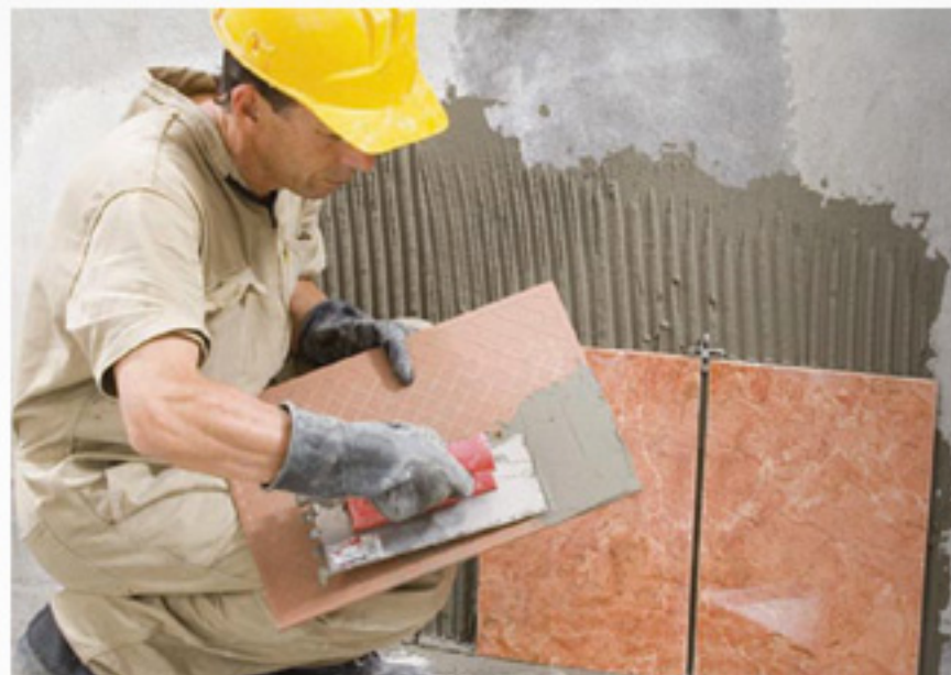
Figura 8-9: Técnica del doble encolado.
