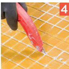
4 Retire el exceso de PEGACOR® con un rascador de juntas. Se recomienda dejar secar 24 horas el PEGACOR® antes de emboquillar.
