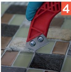
4 Retire el exceso de pegante con un rascador de juntas. Se recomienda dejar secar 24 horas el pegante antes de emboquillar.
