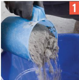
Mezcle 6 1/2 partes de **PEGACOR® BAJO POLVO** por 2 de agua limpia en un recipiente aseado (medidas en volumen) hasta obtener una mezcla de consistencia cremosa y libre de grumos.
