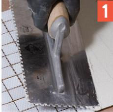
1 Sobre una superficie diferente al piso (para evitar rayado), aplique PEGACOR® en la parte posterior del Mosaico (doble encolado).
