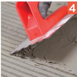
Aplique **PEGACOR® BAJO POLVO** sobre la superficie con el lado liso de la llana haciendo presión y extiéndalo con el lado dentado sólo horizontal o verticalmente.
