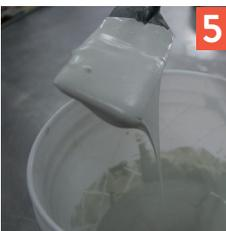
5 En un recipiente aseado agregue una parte de agua limpia y tres partes de CONCOLOR JUNTA ESTRECHA.
